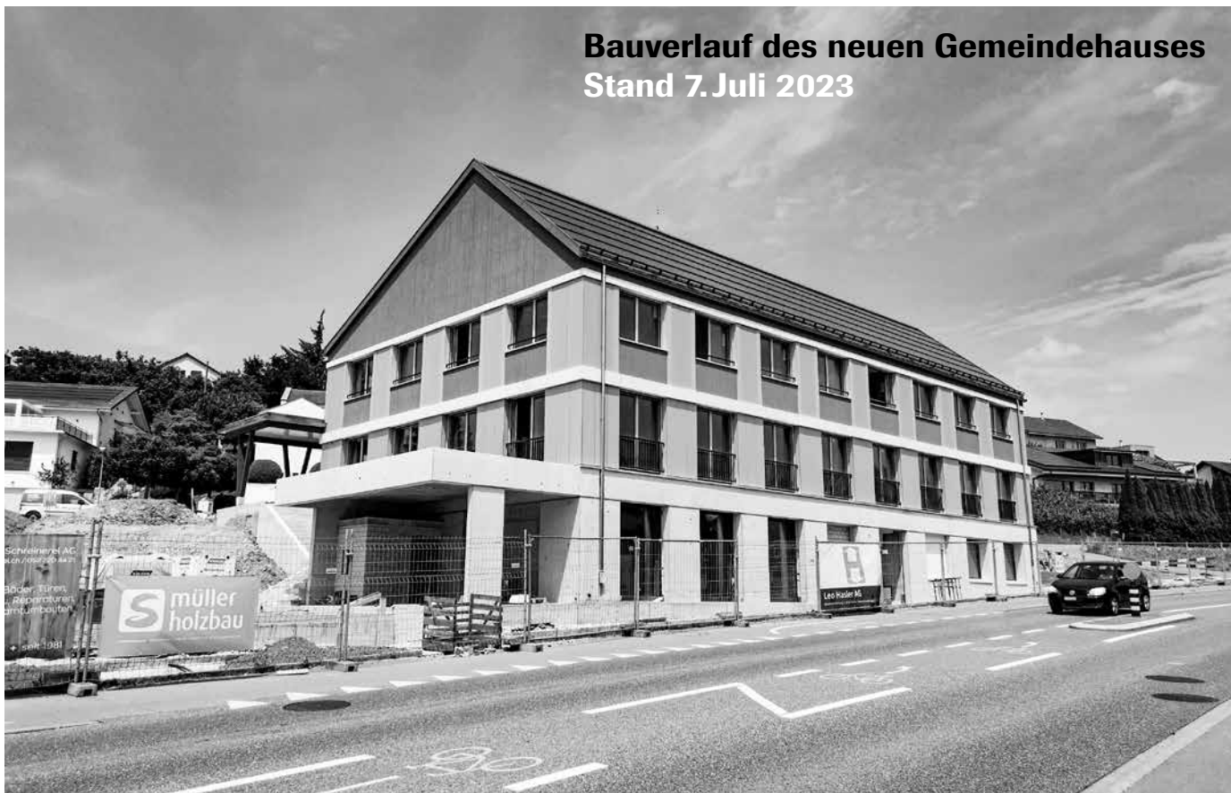
Das neue Gemeindehaus ohne Gerüst
