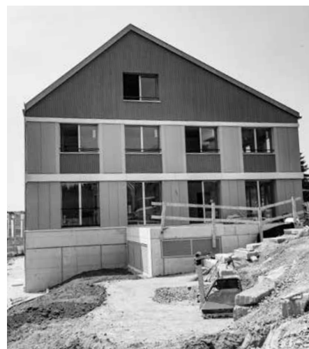
Das neue Gemeindehaus (Ostseite)
