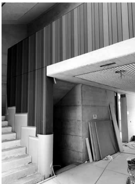
Der Innenausbau ist in vollem Gange
