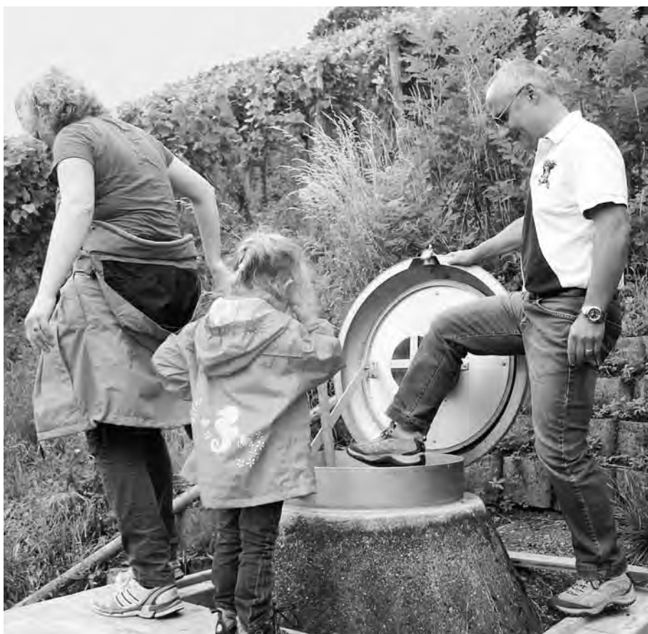
Sandro Schmid steigt in den Schacht der Quellfassung
