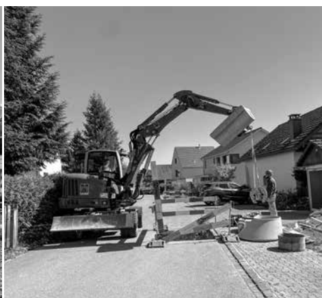
Versetzen von Schächten auf (alte) EW_Spleissmuffen
