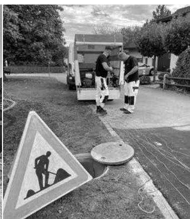
Einzug von Schnüren für den Kabeleinzug
