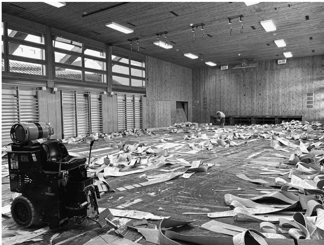
Alter Bodenbelag wird entfernt
