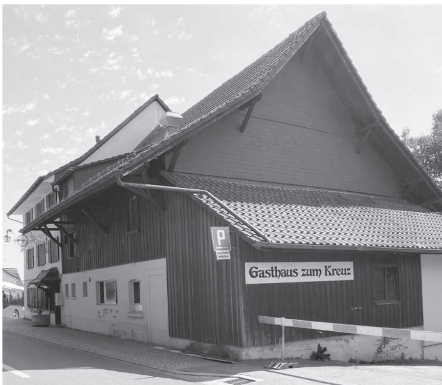
Der Anbau mit Küche musste weichen
